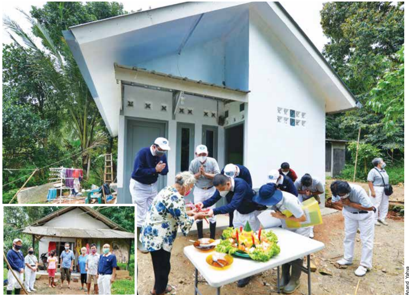
Relawan Tzu Chi Tangerang mengadakan syukuran atas selesainya pembangunan kembali rumah Nenek Cun Nyoh di Kampung Ciresek, Desa Jagabaya, Kecamatan Parung Panjang, Kabupaten Bogor. Sebelum dibangun kembali, rumah Nenek Cun Nyoh tidak layak huni dan kondisinya sangat memprihatinkan (foto insert).
