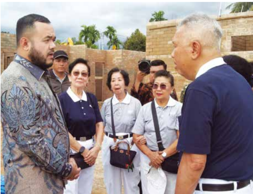
Ketua Tzu Chi Padang (kanan) bersama Walikota Padang meninjau proses pembangunan Huntap bagi para korban bencana banjir dan tanah longsor di Kota Padang.
