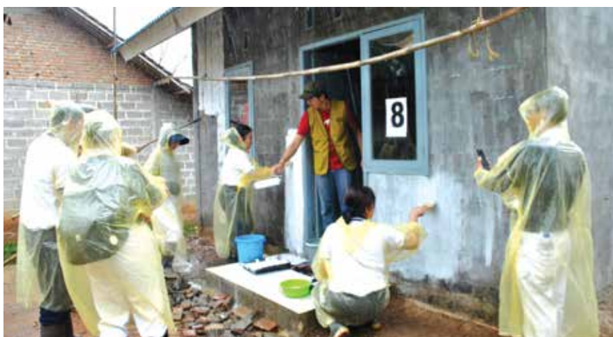
PENGECATAN RUMAH DI JAGABITA (14 JANUARI 2017).
