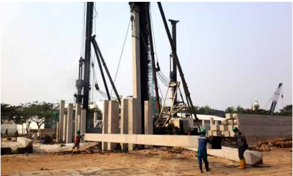
KERJA SAMA. Para seniman bangunan bergotong royong dalam pembangunan tiang pancang untuk pondasi rumah sakit.
