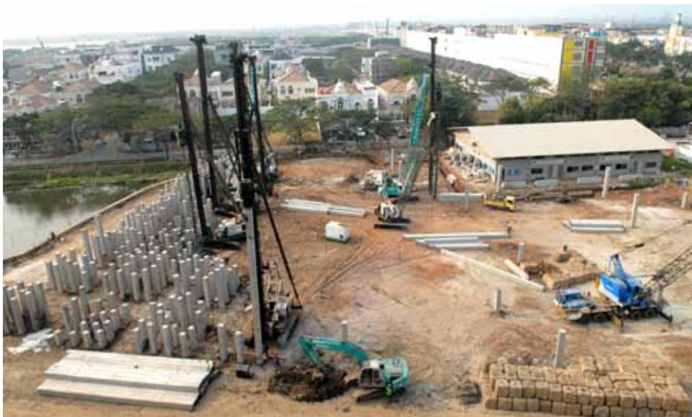
TIANG PANCANG. Pembangunan Rumah Sakit Tzu Chi di Kompleks Tzu Chi Center, Pantai Indah Kapuk, Jakarta Utara memasuki tahap pembangunan pondasi tiang pancang.
