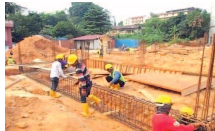
**PERAKITAN BESI.** Para peniman bangunan merakit besi untuk *bekisting sloof* (cetakan tiang fondasi) Aula Jing Si Batam.
