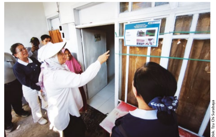
Relawan Tzu Chi Surabaya mendampingi Direktur Jenderal Perumahan Perkotaan Kementerian PKP RI meninjau rumah penerima bantuan renovasi RTLH di Kelurahan Sidotopo Wetan, Kota Surabaya.
