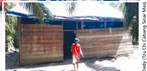
Relawan Tzu Chi Cabang Sinar Mas komunitas Perawang 2 dari PT. Arara Abadi menyerahkan rumah yang telah selesai dibangun kepada Tuah dan Sirah, warga Dusun Minas Asal, Desa Minas Barat, Kecamatan Minas, Siak, Riau.
