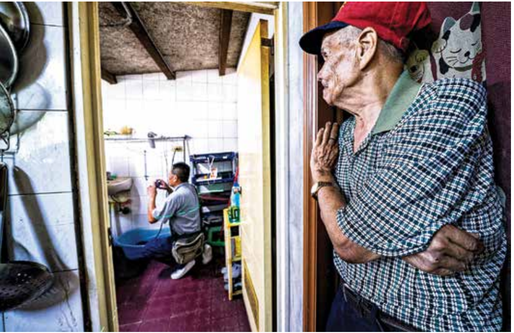
Relawan Lin Shi-jie (kiri), seorang tukang profesional, memeriksa dinding dengan pemindai dinding untuk menghindari kabel listrik dan pipa air sebelum memasang pegangan tangan di kamar mandi. Zhan, sang pemilik rumah, melihat ke dalam dengan rasa ingin tahu dari pintu.
