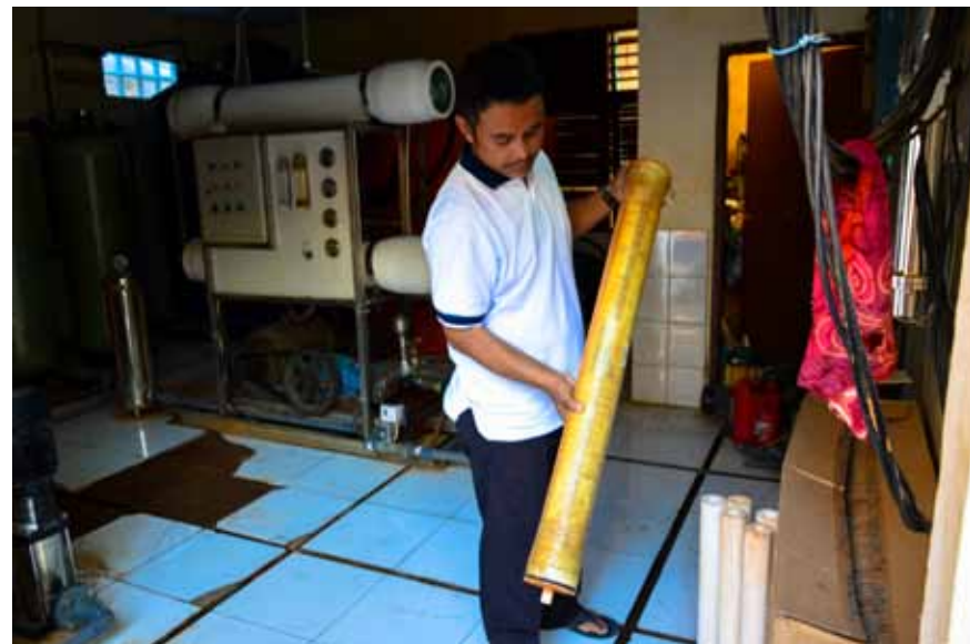
MENGABDI. Santani, Operator RO Pulau Panggang menunjukkan membran yang digunakan oleh mesin RO. Bekerja sebagai operator merupakan bentuk pengabdian bagi insinyur perkapalan itu.
